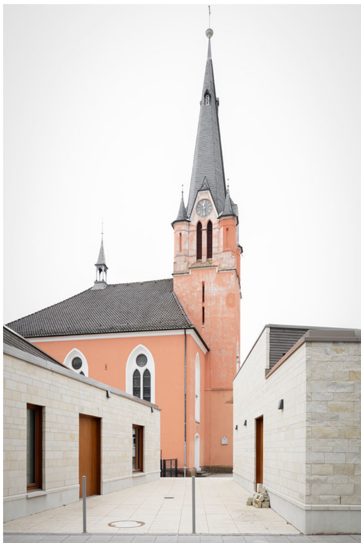
kita und gemeindehaus in hainholz
